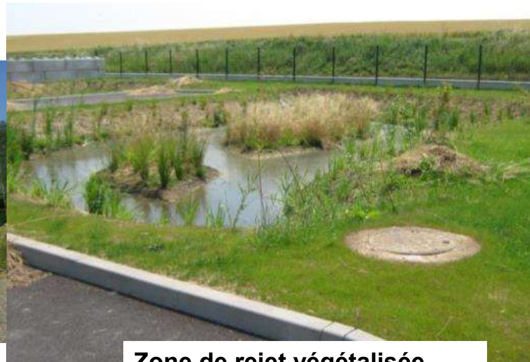
Zone de rejet végétalisée
