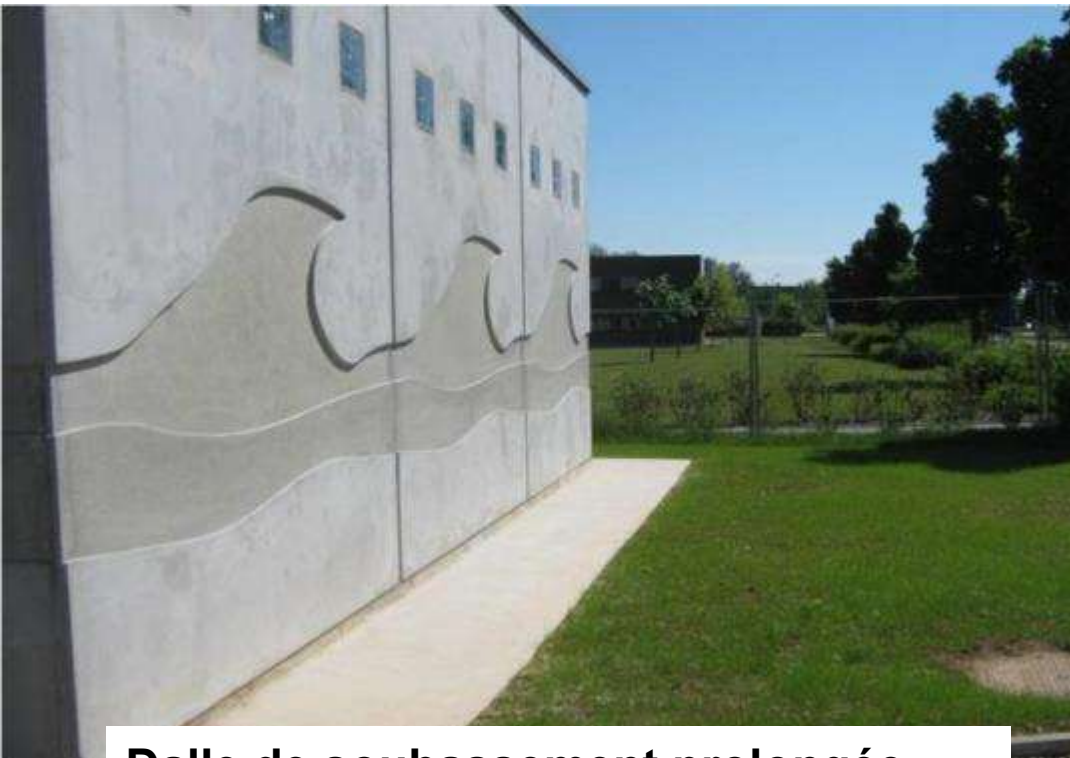
Dalle de soubassement prolongée
