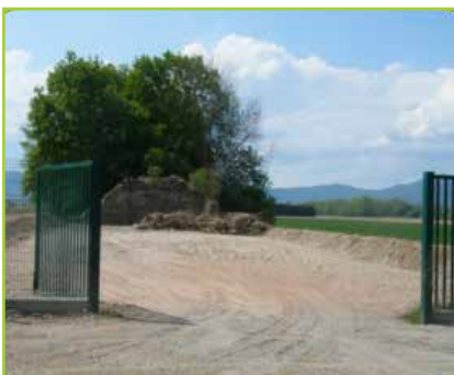
Création de plateforme de stockage et tri des flottants à Sélestat et Erstein
