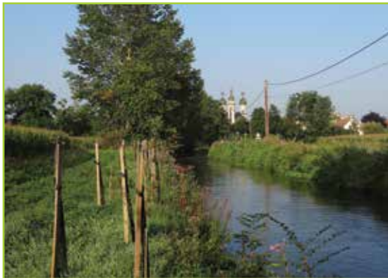
Replantation de ripisylve et protection de berges par techniques végétales
