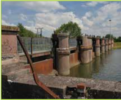
Rénovation du barrage de la Steinsau : protection d'Erstein et Strasbourg contre les crues, franchissabilité piscicole, nautique et production hydroélectrique
