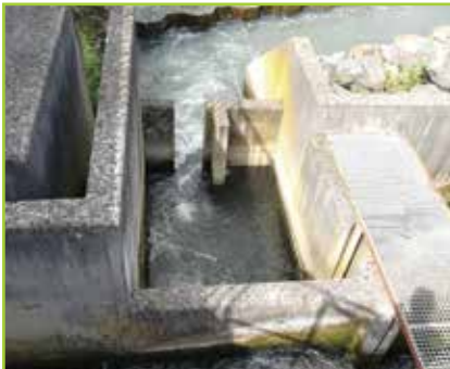
Création de passes à poissons et station de vidéocomptage des anguilles et saumons à Huttenheim
