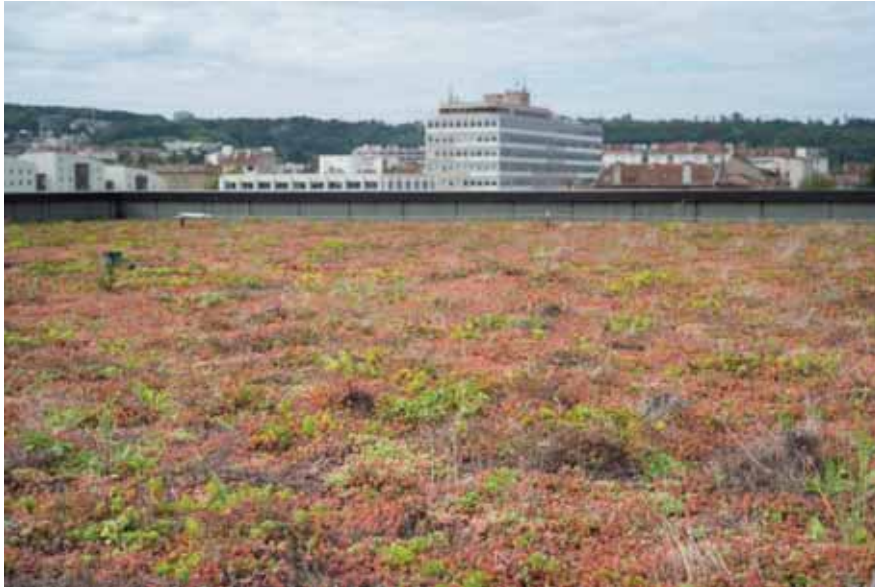
Figure 9 : Toiture végétalisée sur le campus ARTEM à Nancy (54) - AERM
