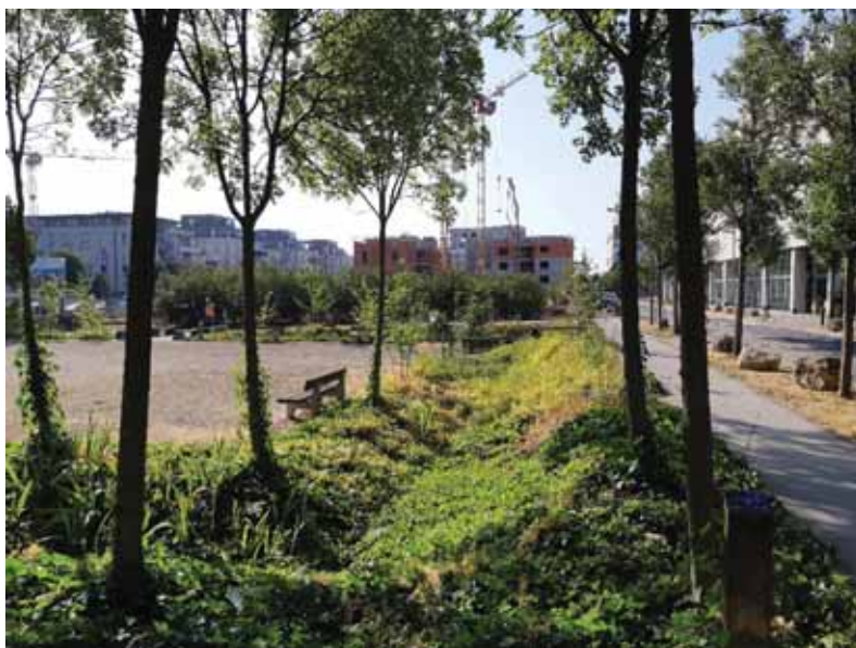
Figure 6 : Noue d'infiltration, Nancy (54) - AERM
