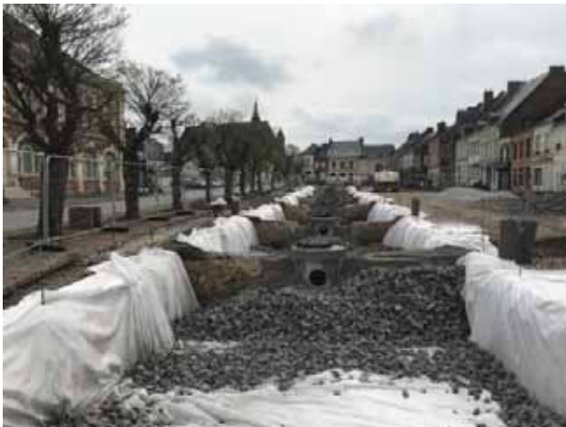
Figure 4 : Chaussée à structure réservoir en cascade à Montcornet (08) (©Ingessia) et parking de 20000 m 2 en structure réservoir cloisonnée, alimentée par des noues d'infiltration à Yutz (©AERM)
