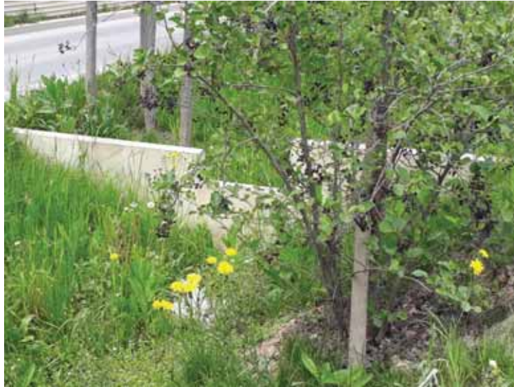
Figure 3 : Noue à redans le long d'une voirie – ARNOULD W.
