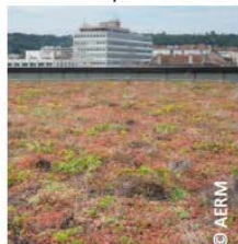
Toiture végétalisée (Épaisseur minimum de 8 cm)
