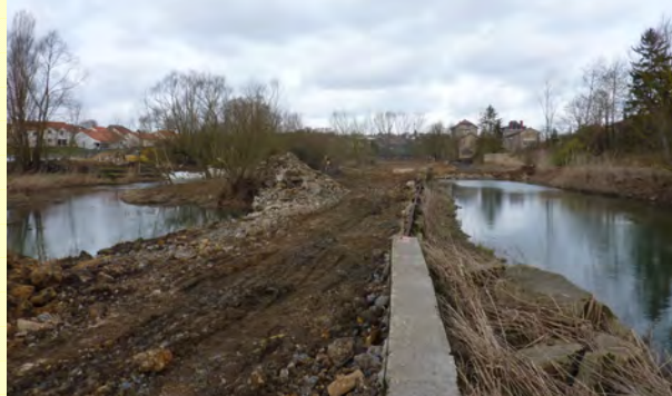
Travaux de destruction en cours (mars 2011)
