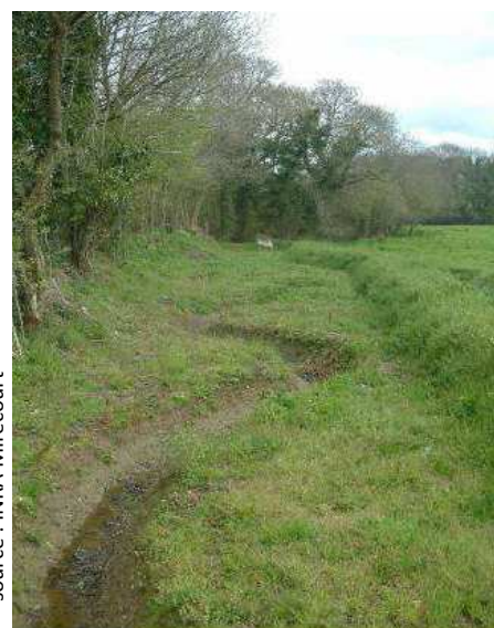
Aménagement de sortie de drain par un fossé sinueux
