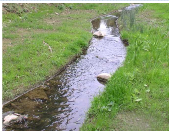
Création de banquettes végétalisées avec mise en place de blocs de diversification
