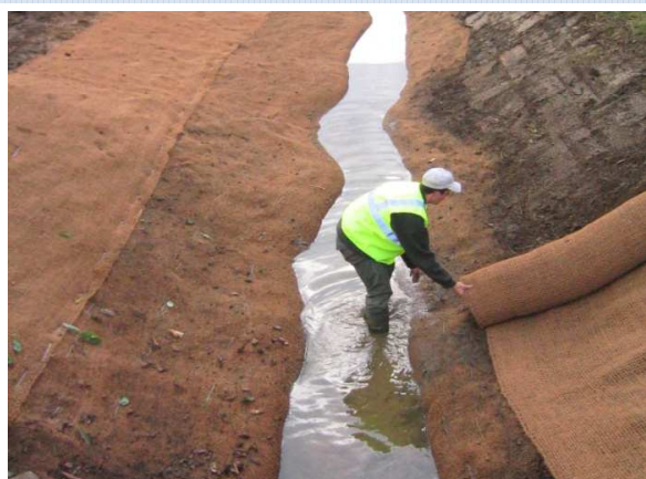
Travaux de création de banquettes et protection des berges
