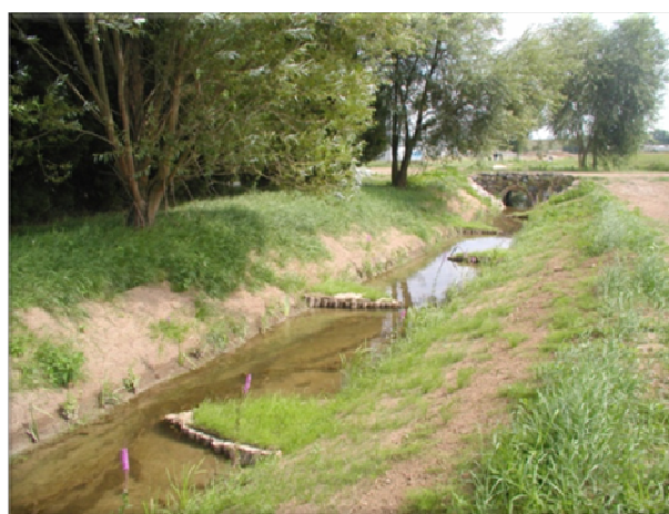
Exemple d'épis (pieux bois et végétalisation)
