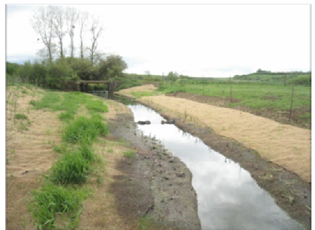
Exemple de rétrécissement par curage raisonné avec création de risbermes végétalisées
