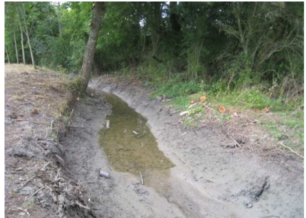
Exemple de retrait raisonné de sédiments pour création d'un lit mineur d'étiage
