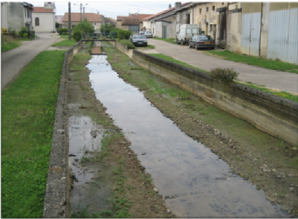
Exemple de remodelage du lit mineur par déblai avec création de banquettes latérales
