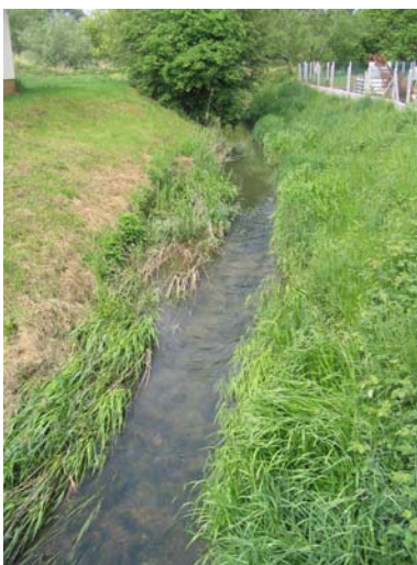
Exemple de rétrécissement du lit par création de banquettes végétalisées
