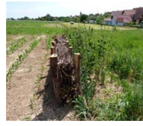
Installation de fascines
